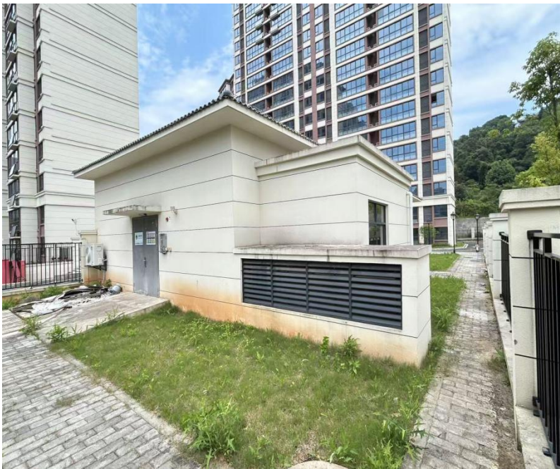
（竣工人防出地面楼梯间实景照片）
