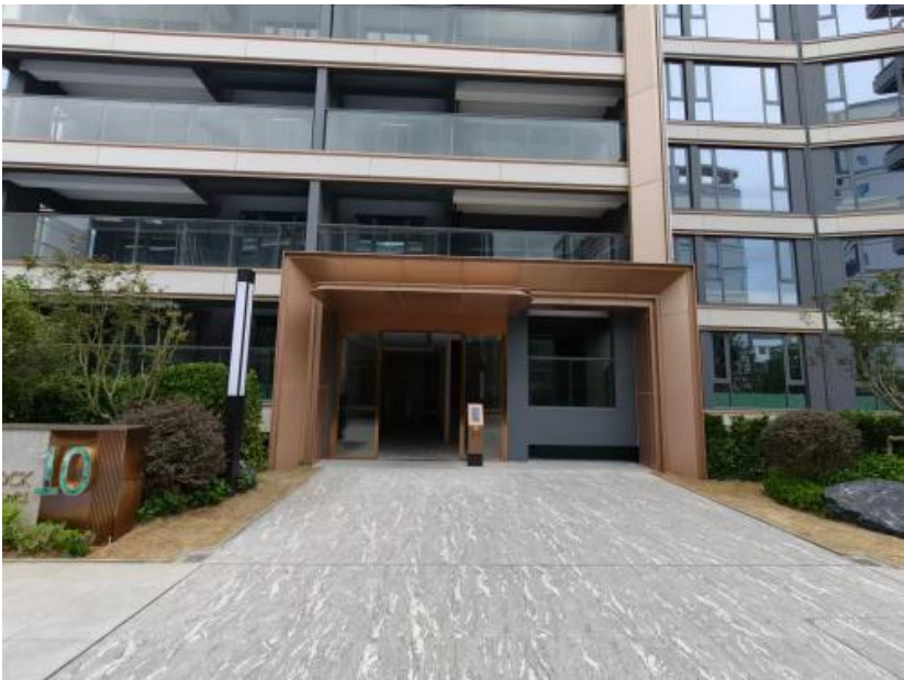
（竣工 10#栋一层入户门厅门廊实景照片）
