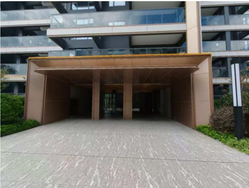
(竣工 9#栋一层入户门厅门廊实景照片)
