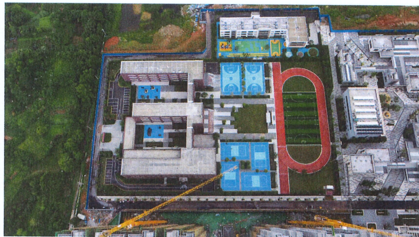
航拍全景竣工图
