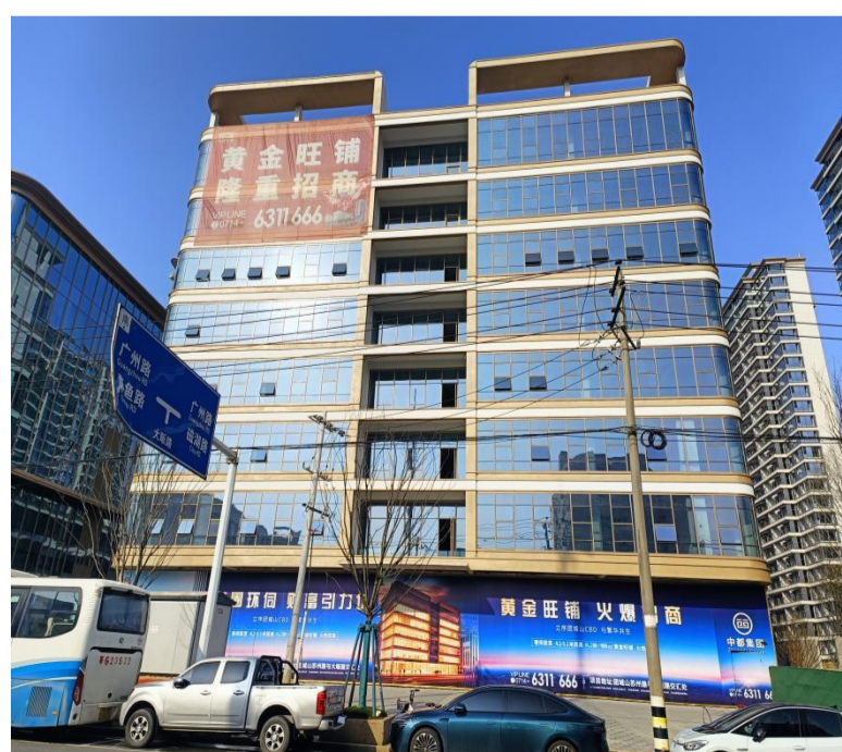
15#楼东面一层竣工外立面
