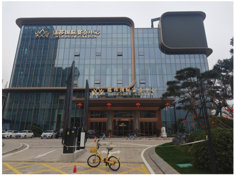
16#楼屋面层竣工外立面
