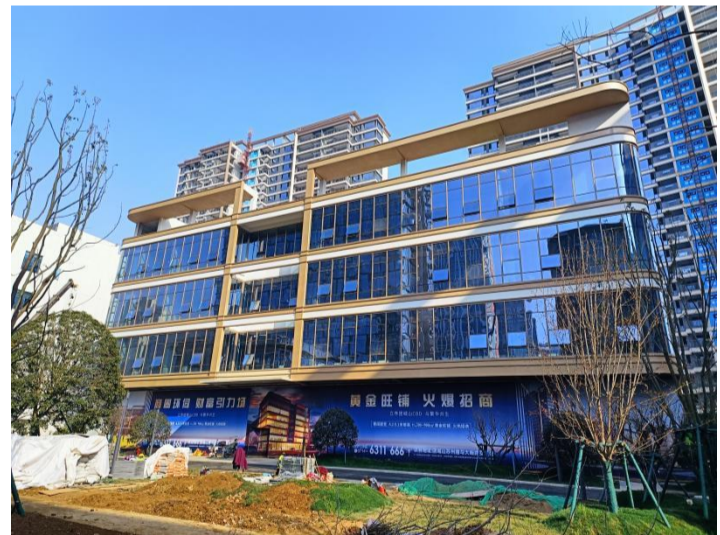
12#楼南面一层竣工外立面
